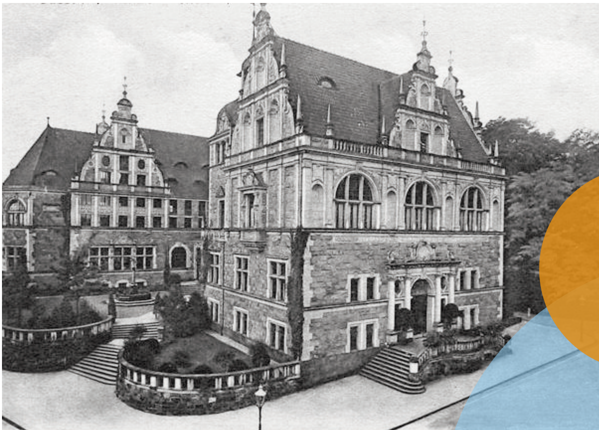
Die Murhardbibliothek, 1905 erbaut
